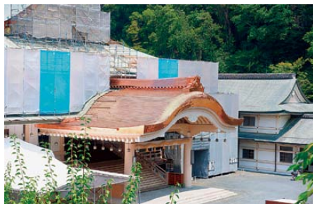
銅板屋根が新しくなった大拝殿
